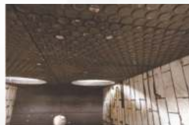
резино-керамические плиты толщиной 32 мм загрузочный желоб
